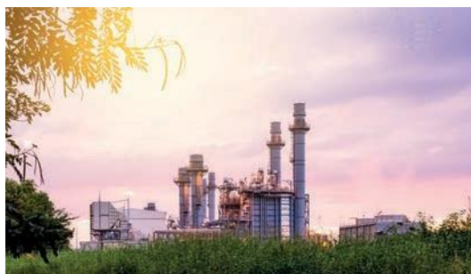
Centrale à flamme au gaz, énergie fossile
